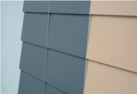
La sous-structure du système Siding convient parfaitement à la conception d'une façade en dalles TONALITY avec un aspect de pose à clin. Tous les types et toutes les tailles de dalles peuvent être utilisés avec cette sous-structure. L'inclinaison et le chevauchement des dalles TONALITY sont obtenus par la forme des profilés de la sous-structure du système Siding.
